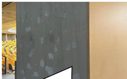
柱に粘着力の強いテープを貼ってしまうと、柱の塗装がはがれて、ひどい状態に。
